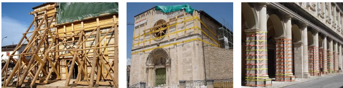
Figura 7: Procedimentos de consolidação temporária
