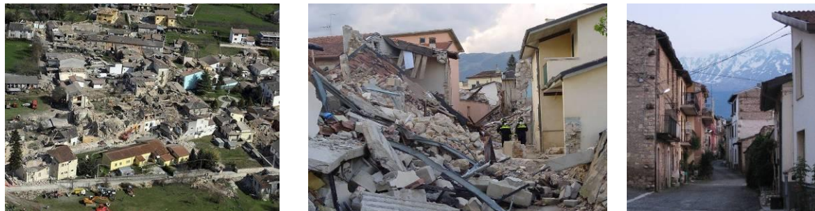
Figura 4: Danos em estruturas de alvenaria: a) Vista geral de Onna; b) Vista da rua principal de Onna; c) Vista de uma rua de Montichio
