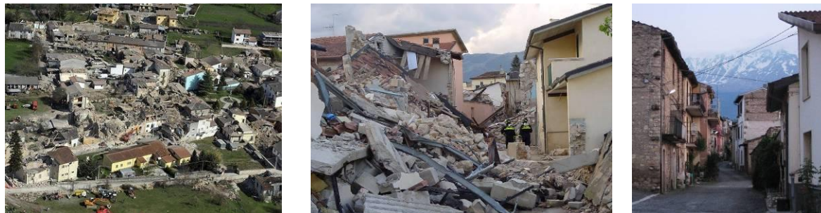
Figura 4: Danos em estruturas de alvenaria: a) Vista geral de Onna; b) Vista da rua principal de Onna; c) Vista de uma rua de Montichio
