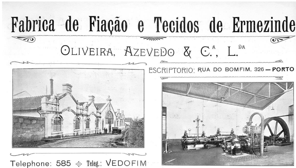
Fig. 6 - Fachada e casa das máquinas da Fábrica de Ermezinde, em 1918 ( Álbum das Fábricas , 1918).
