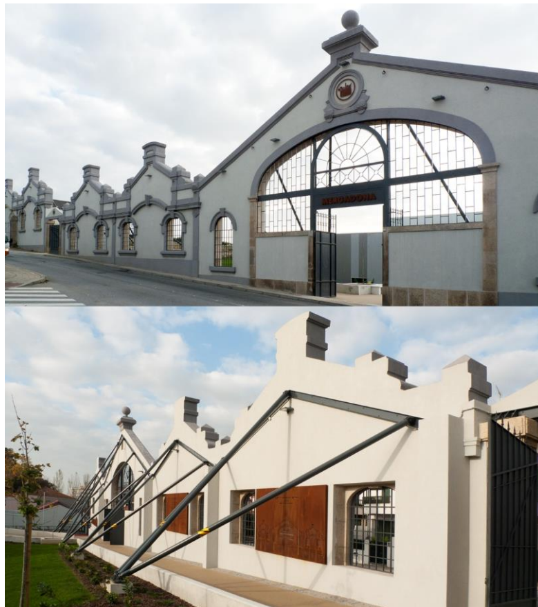
Fig. 7 - Fachada e contrafachada da fábrica, com respetivas escoras de amparo (©MBPastor, 2020).
