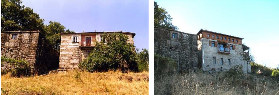
FIG 7. Fachada nascente do edifício existente e depois de intervençionado (Cabral, 2007)
