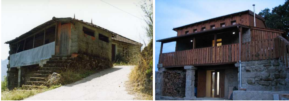
FIG 6. Fachada norte do edifício existente e depois de intervençionado (Cabral, 2007)
